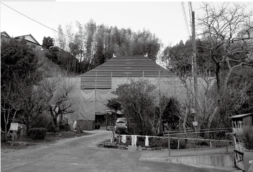
千葉県成田市の緑豊かな里山に建つ長寿院。現在は本堂の新築工事中(取材日 令和2年2月)
